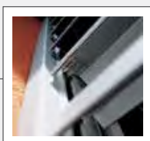
Jede Lamelle einzeln seitlich befestigt
